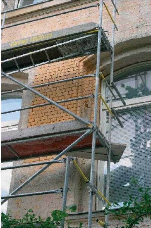
Musterfläche zur Fassadensanierung
